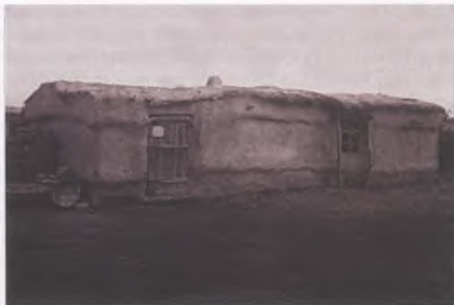
Төбесінде мұржасы көрініп тұрған қабырға пешпен ортасы бөлінген там үй. ҚР МОМ қорынан (НКП 1526)
