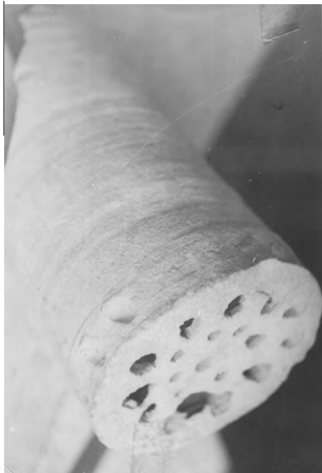
Рис. 30. Глиняное сито, процеживающее воду в центральной водопроводной системе
