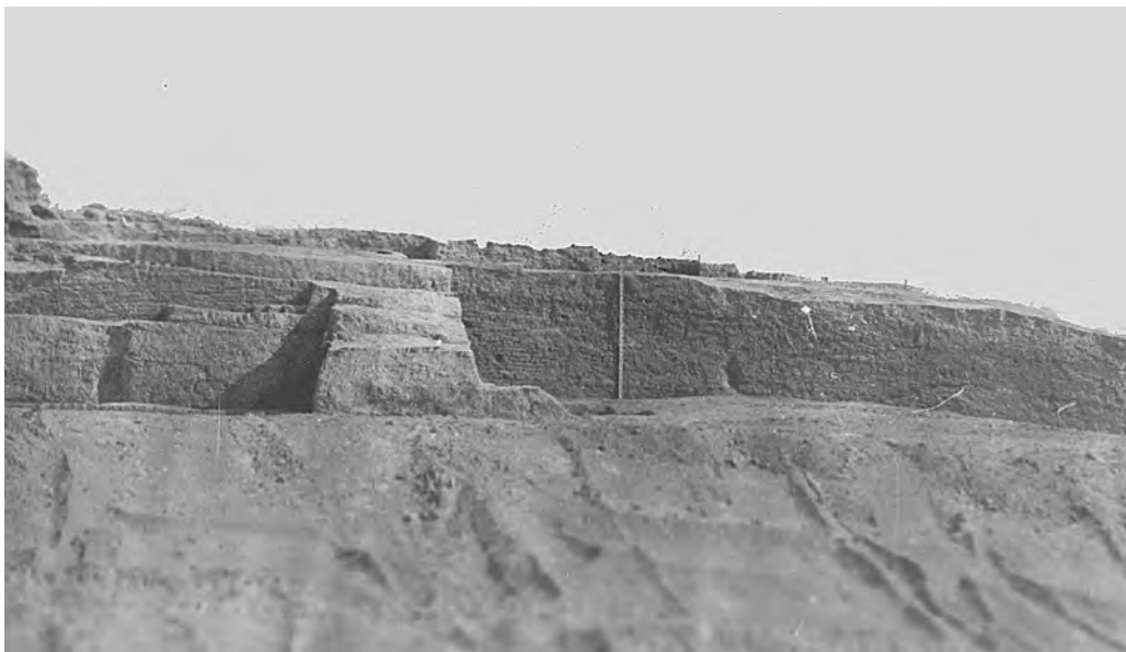
Рис. 13. Вид юго-западной крепостной стены цитадели Актобе
