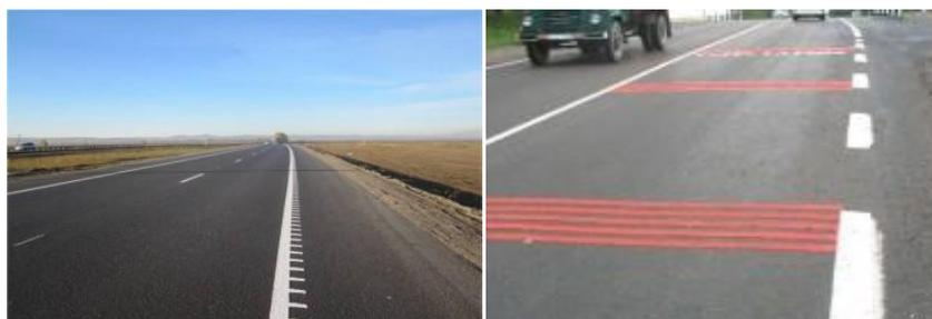
Рис. 4.19. Шумо-вибрационная разметка дороги
