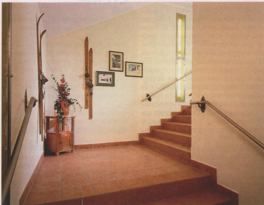
Перила в форме доски с кантом неудобны. При монтаже перил следует устранять возможность соскальзывания руки в месте, где они заканчиваются.
