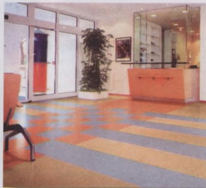
Каучуковые покрытия настиляются так же, как и покрытия из ПВХ. При больших нагрузках нанесение защитного слоя позволит облегчить уборку и уход за напольным покрытием.
