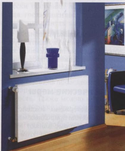
В зависимости от модели батареи необходимо очищать вентиляционную решетку, напольное покрытие, крепёж к стене.
