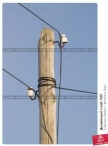
Способность древесины *сопротивляться* прохождению через неё электрического тока характеризует такое её свойство, как **электропроводность**.
