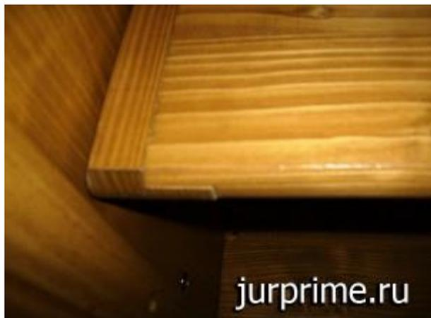
При изготовлении столярных изделий существуют определённые правила. В том числе и как располагать волокна в изделии. Опытные мастера уже автоматически формируют детали так, как положено, но и они иногда допускают ошибки.
