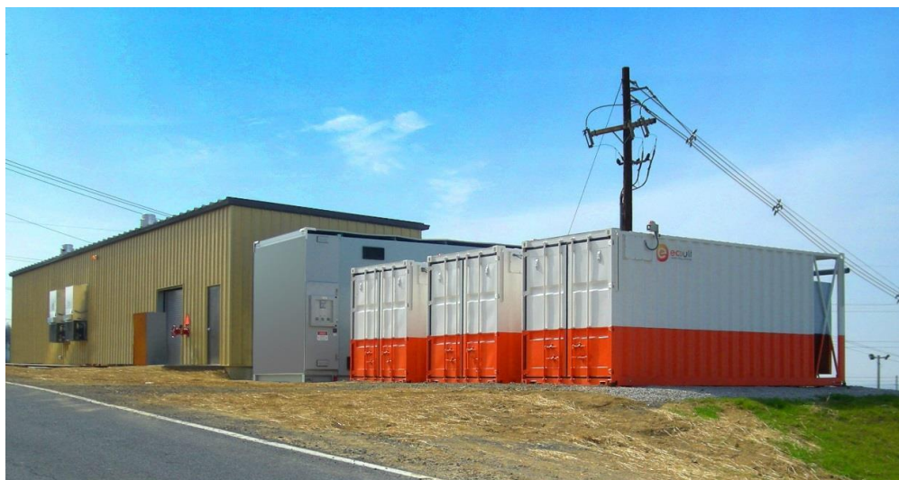
Рисунок 3.16 Накопитель 3MW UBER TM и система управления Ecoult на PJM Interconnection
