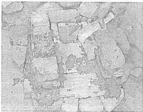
Пештің екінші және ішкі қабатына шамоттан (огнеупорный) оңделген кірпіштерді қалау әдісі
