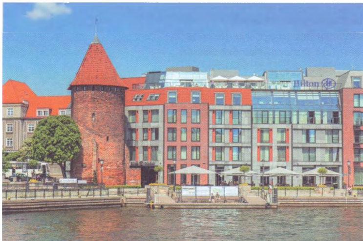
Hilton қонақүй корпорациясы дивизиондық ұйым дизайны тәсілін қолданады. Garden Inn., Hampton Inn. және Hilton сынды қонақүй брендтерінің кейбірі бөлек бөлімше ретінде жұмыс істейді.
