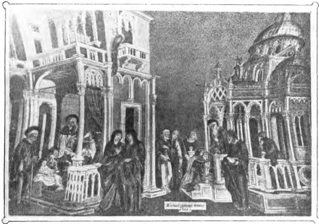
Рис. 163. Пример деформации мозаики на цилиндрическом своде
